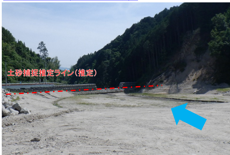
土砂捕捉前 (R2.6.2撮影)
