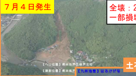
がけ崩れ 熊本県葦北郡芦北町田川
