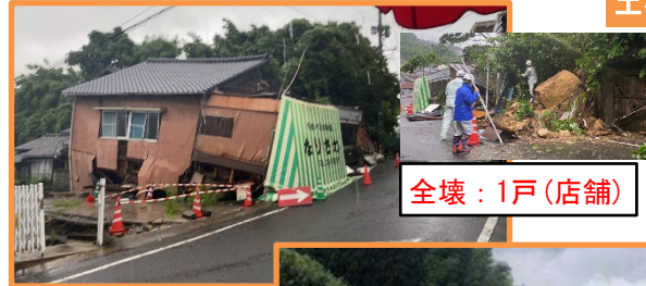
がけ崩れ 長崎県佐世保市大黒町
